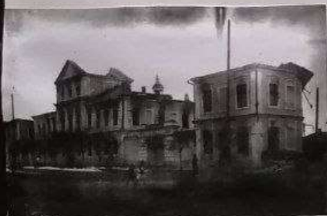
РАЗРУШЕННОЕ ЗДАНИЕ МАГИСТРАТА
