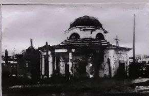
ПОВРЕЖДЕННОЕ ЗДАНИЕ КРЕСТОВОЗДВИЖЕНСКОЙ ЧАСОВНИ-РОТОНДЫ
